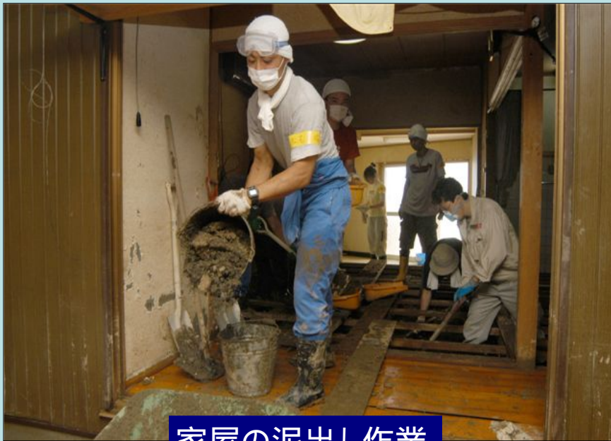
家屋の泥出し作業
