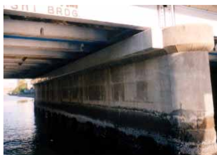
きょうざかくふく 橋座拡幅
