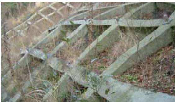
従来の法枠工法(写真上)と頭部連結型補強土工法(写真右)
