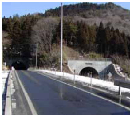
八田部側から見た新旧トンネル
