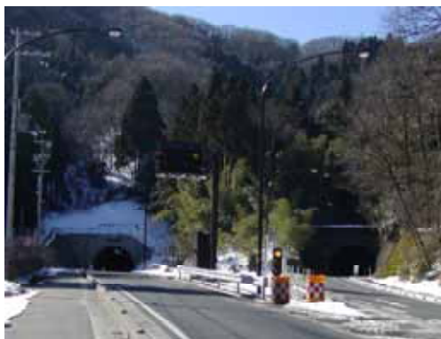
岩熊側から見た新旧トンネル
