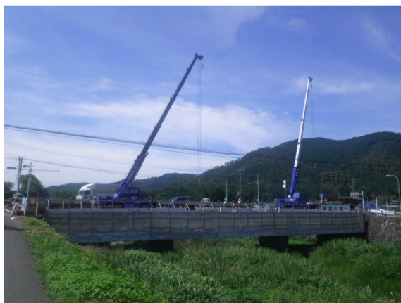
伊香具橋 修繕工事(木之本町大音、田居地先)
