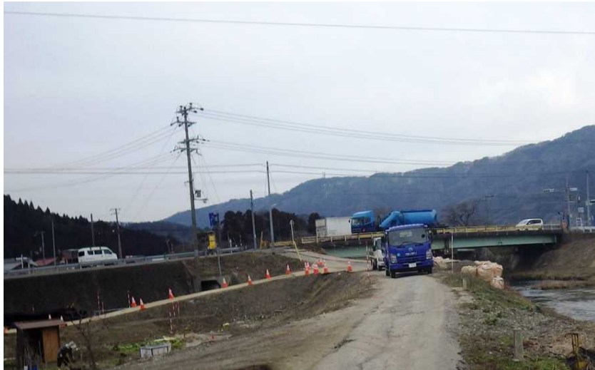
・余呉川河川改修のネックとなっている国道橋(賤ヶ岳橋)の架替えを推進します。
