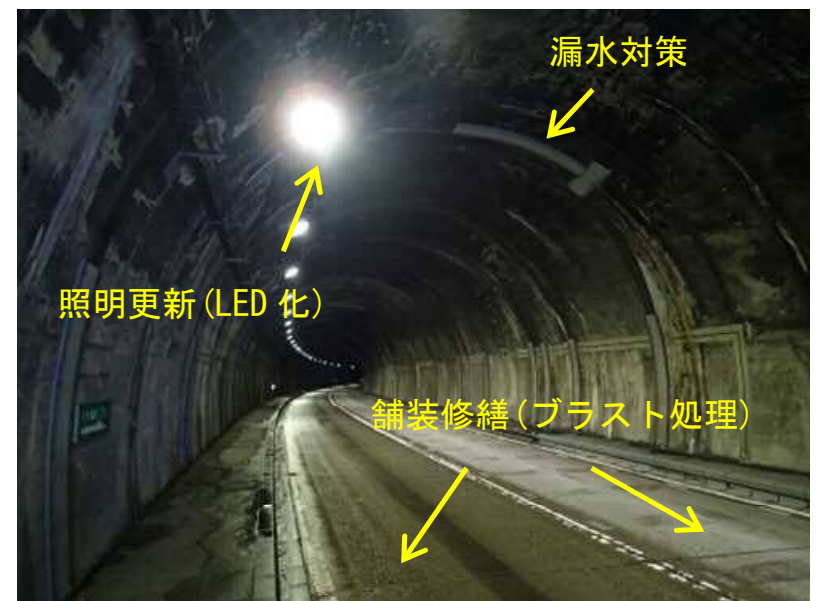
国道303号 奥琵琶トンネル
