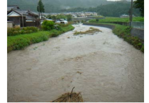
7月14日豪雨での荒川状況 勅使野橋より上流を望む
