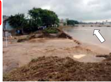
木田橋上流左岸破堤箇所(足羽川ダム)
