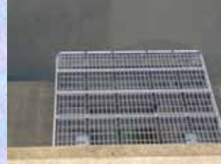
堤頂から見たスクリーン
