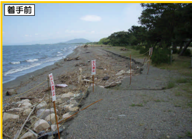
砂浜の敷き均し・砂の補充
