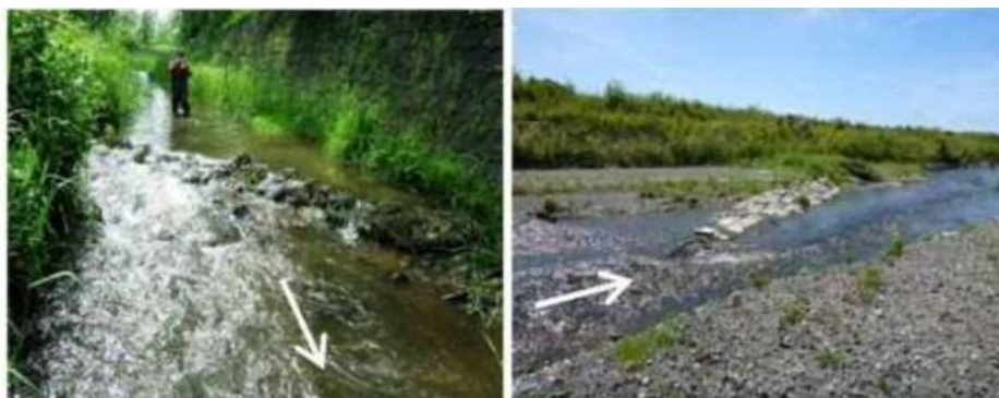
図 4.7 バープエ (上向き水制) による寄り州、河床形状や流れの形成 1)
