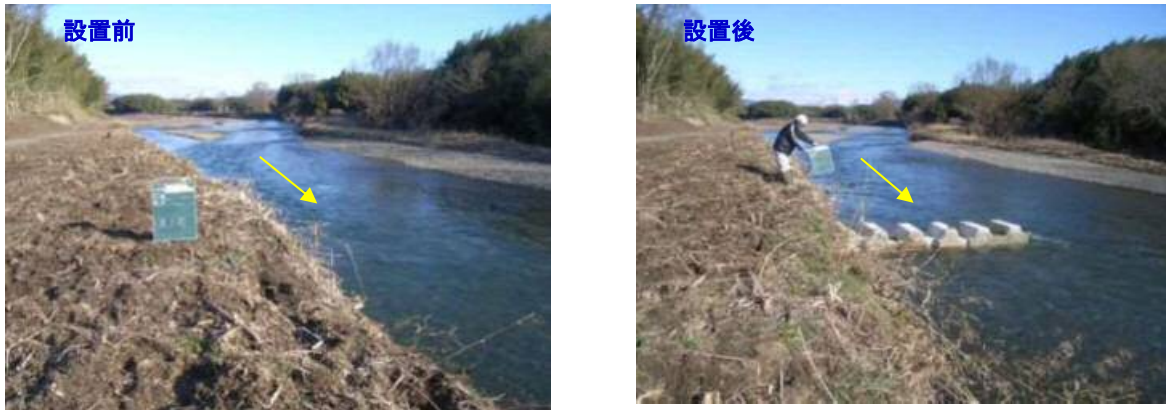
図 5.2 試験施工の実施例（高時川 6.0k 付近）
