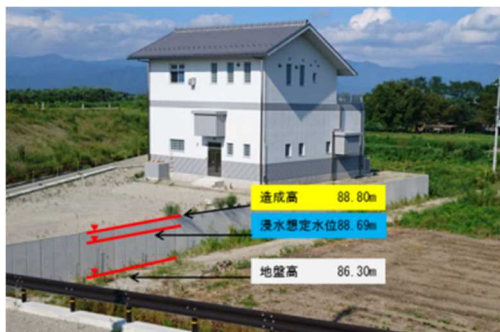
図-3 姉川中継ポンプ場の嵩上げ状況
