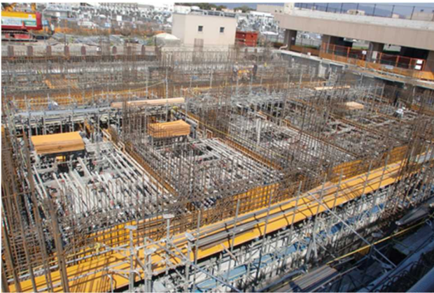
写真5 配筋状況(最初沈殿池)
