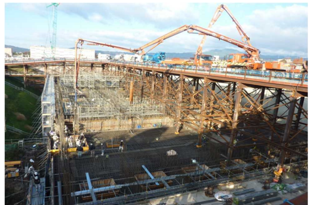
写真7 コンクリート打設状況
