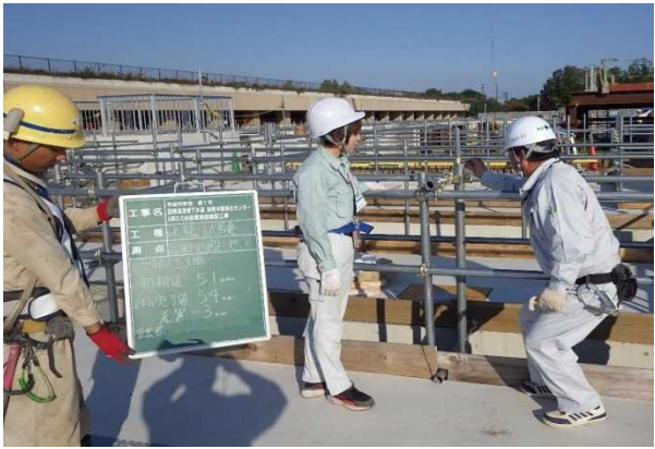
写真-9 水張試験状況
