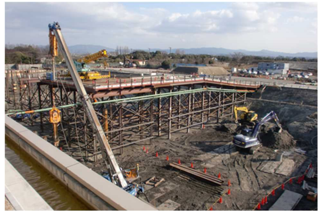
写真-2 仮設栈橋の架設状況
