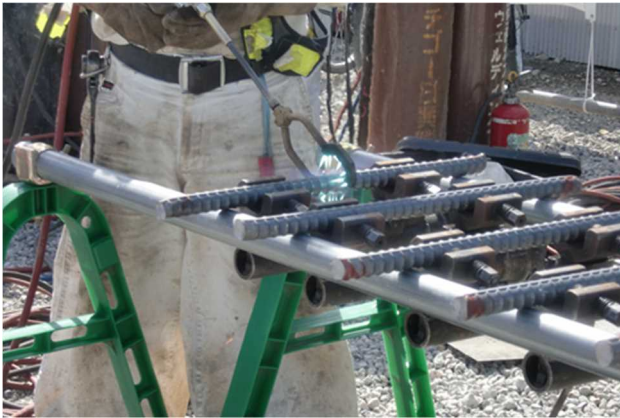
写真4 ガス圧接状況 (施工前試験時)
