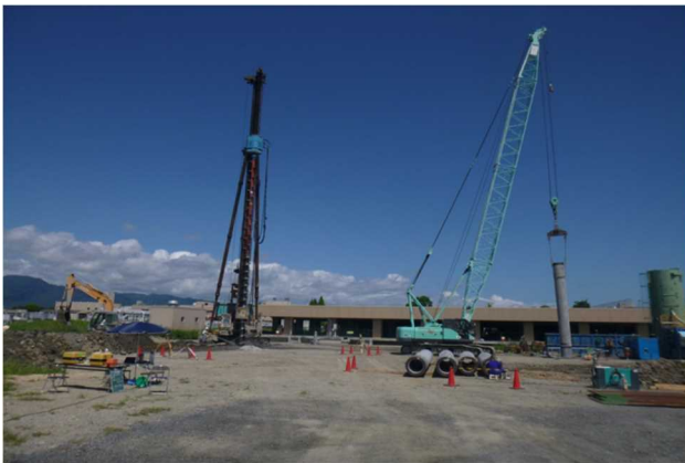
写真-1 オーガによる先行掘削、既製杭建込状況
