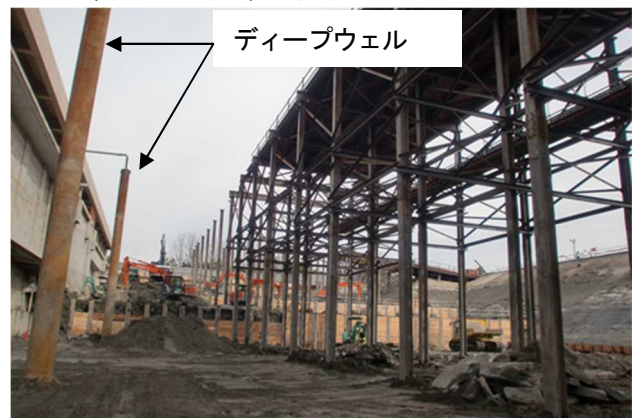
写真-3 ディープウェル稼働状況
