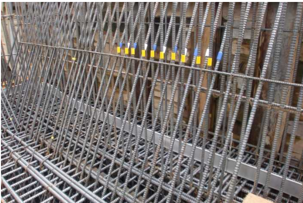
写真6 配筋状況 (ハンチ部)
