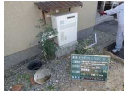
写真-3 誤接続調査
