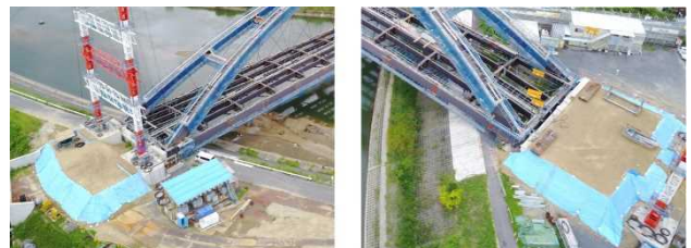
写真-7 補強盛土（左 A2、右 A1）
