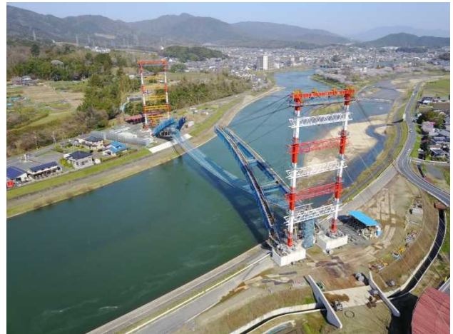
写真-1 架設時の写真 (H29.4)
