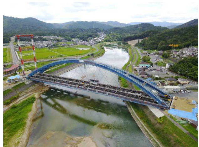
写真-6 補剛桁閉合時（H29.8）
