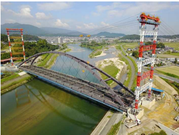
写真-9 架設完了時（H29.8）
