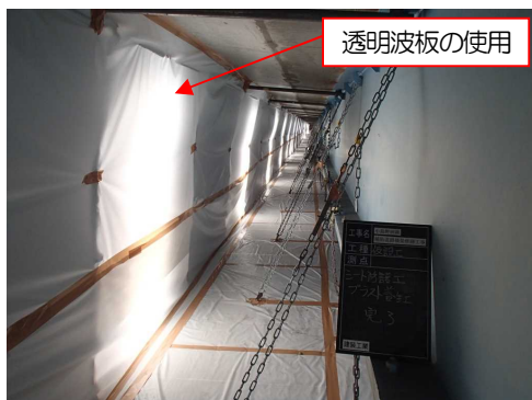
写真-7 密閉式吊り足場内の明かり取り
