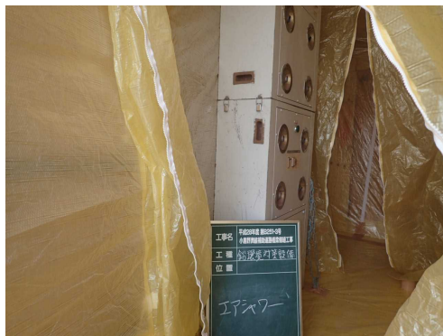
写真5 エアシャワーの設置状況
