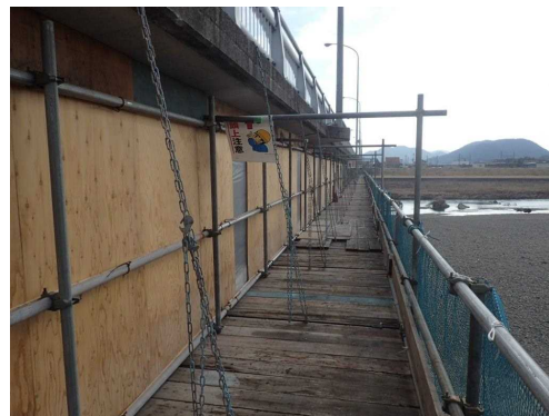
写真-6 緊急避難通路
