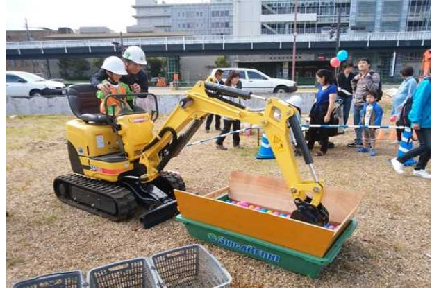
図-9 バックホウ ボールすくい体験
