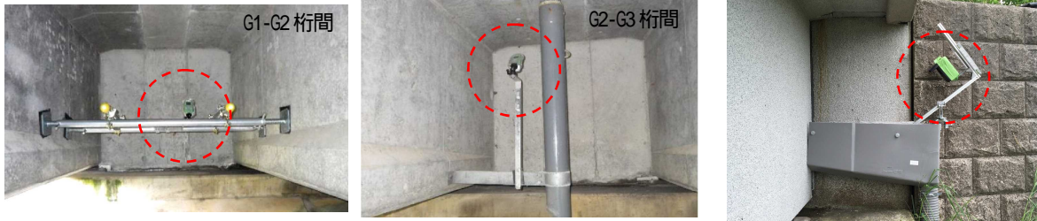
写真-6 効果観察用のインターバルカメラ設置状況 (赤破線部がカメラ)
