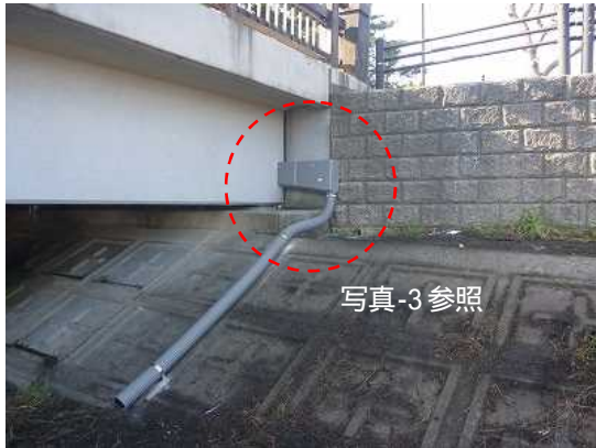
写真-2 簡易排水装置の設置状況
