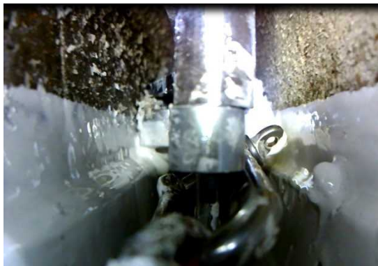
写真-8 止水材を塗布する状況
