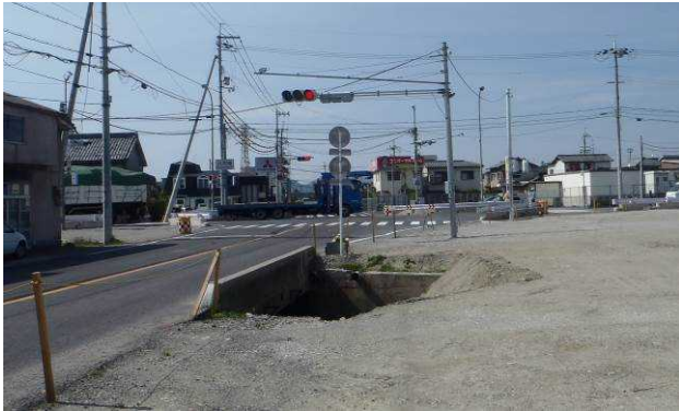
写真-1 旧三明川閉塞箇所（本工事閉塞箇所）
