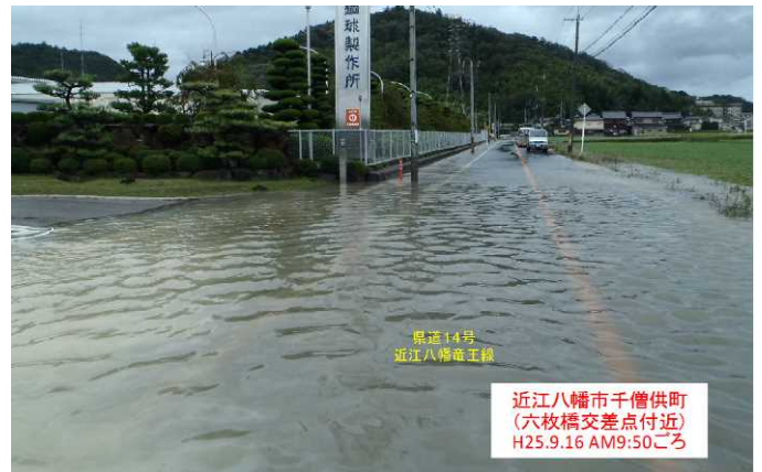
写真-3 台風18号・冠水状況
