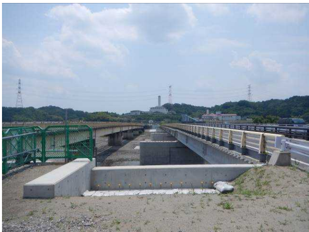
(写真-1 新設橋上部工 施工前)
