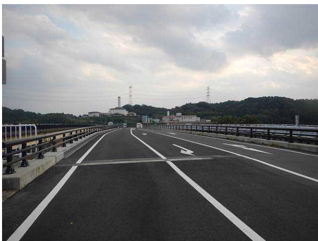
(写真-2 新設橋上部工 完成後)
