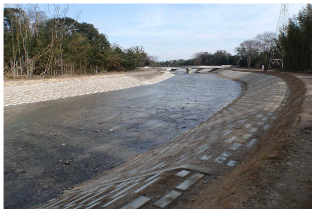
図 - 18 工事完成（中道橋より上流を望む）
