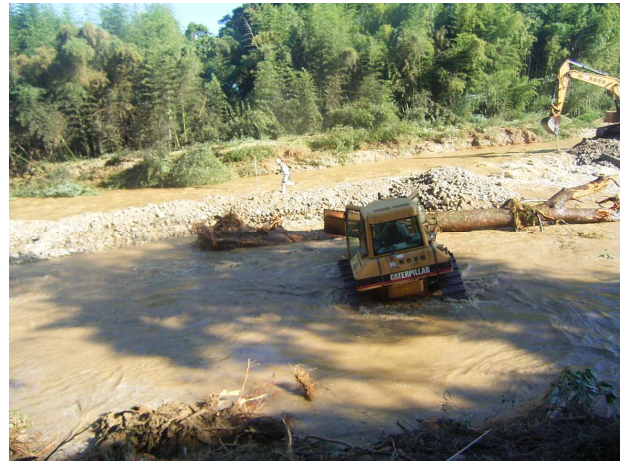
図 - 13 応急復旧2日目の施工状況
