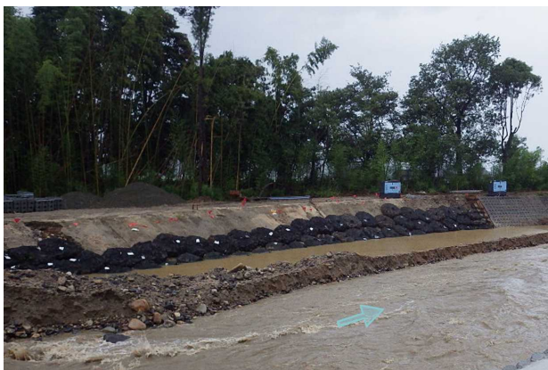
図 - 17 台風11号対策状況（大型土のう）
