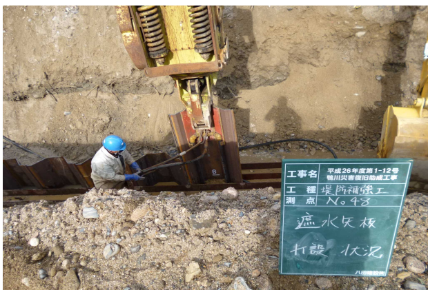
図 - 16 現地施工状況（遮水矢板打設）
