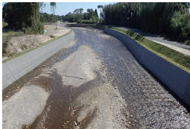
図 - 20 工事完成（行司橋より下流を望む）
