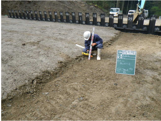
写真.5 打ち止め部処理
