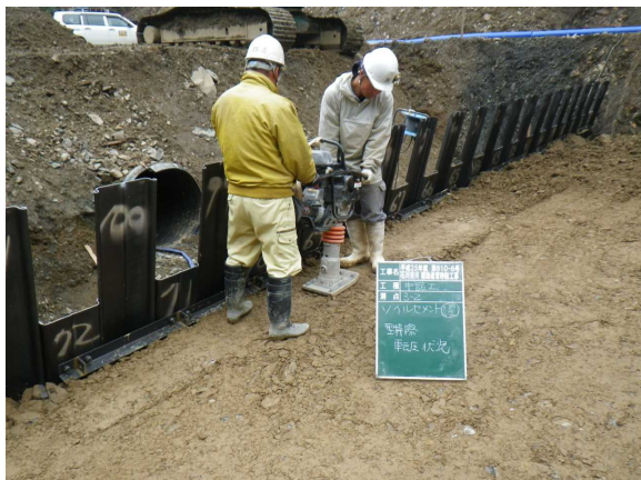
写真.7 連結金具周辺の転圧状況
