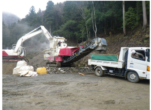
写真.3 リテラによる攪拌・混合
