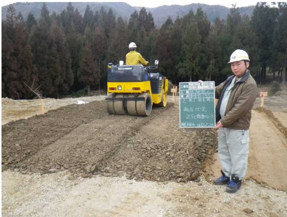
写真.2 試験施工 締固め
