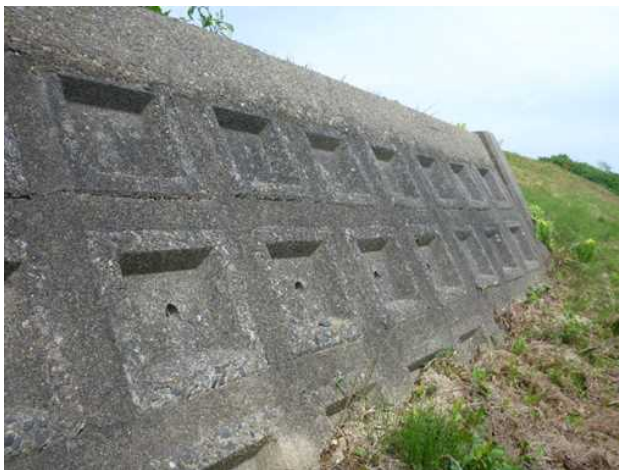
図-16 堤脚部擁壁
