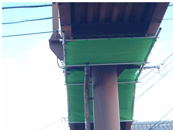
写真-2 落下防護ネットの設置
