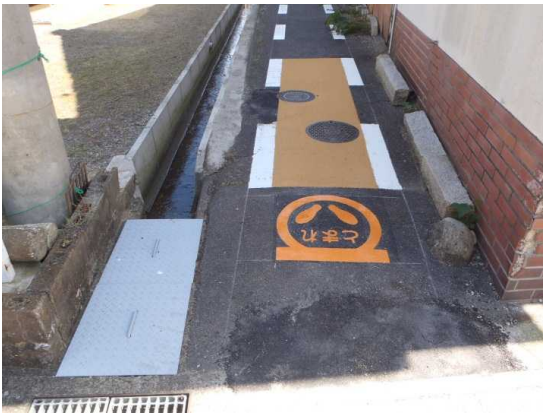
写真-4 里道（誘導線・とまれマーク設置、蓋掛け）
