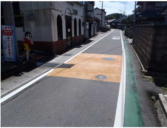
写真-3 市道（カラー舗装、外側線・徐行マーク設置）
