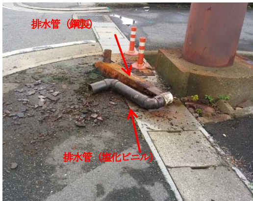
写真-1 落下した排水管
