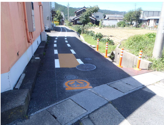
写真-5 里道（ポストコーン設置）
