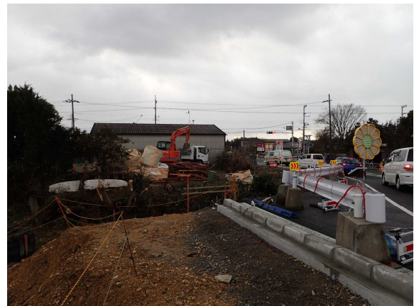
図-9 撤去状況 (物件 B)
