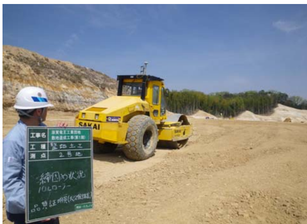
図-4 情報化施工に対応した振動ローラ施工状況
