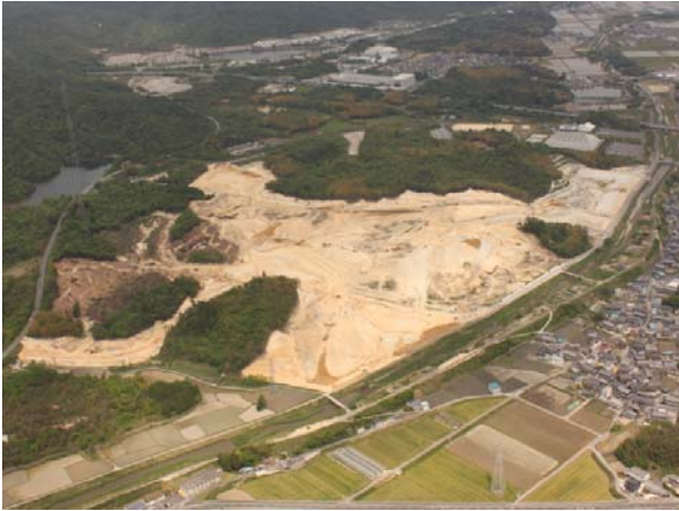
図-1 滋賀竜王工業団地造成箇所の航空写真
