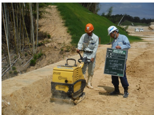
図-5 エコマイザ搭載コンパクタによる剛性確認状況
