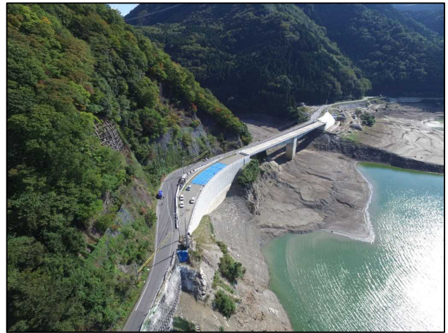
写真-1 国道 421 号 道路改良工事現場 (東近江市萱尾町地先)
