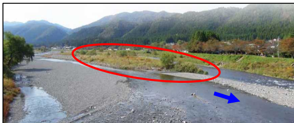
写真－2 実施箇所
