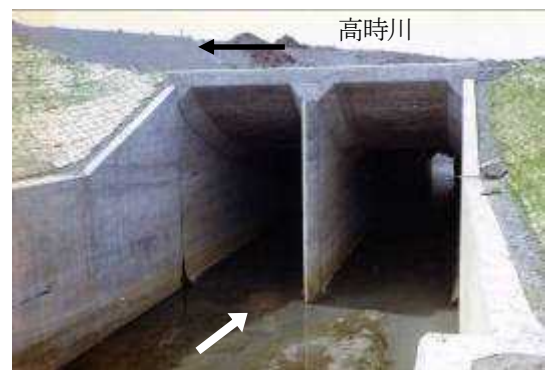
(写真6 竣工時の田川カルバート※)
