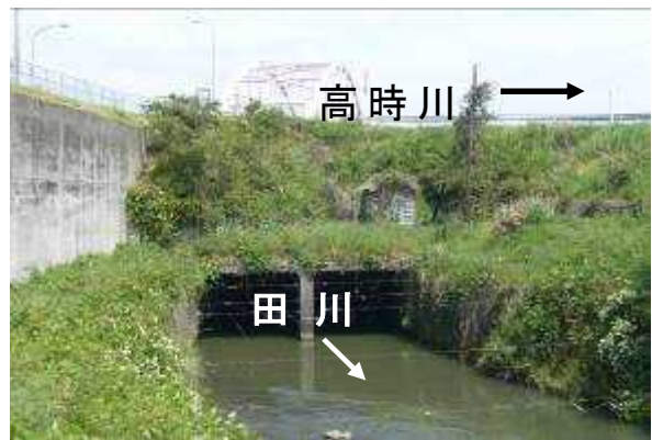
(写真1 現在の田川カルバート)
