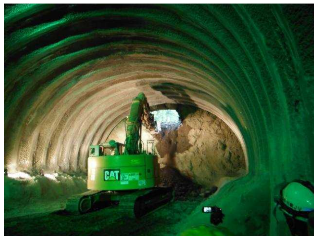
図 - 1 4 トンネル貫通 (2013年10月8日)
