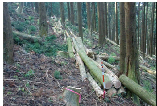
写真11：間伐材を等高線上に並べた筋工
