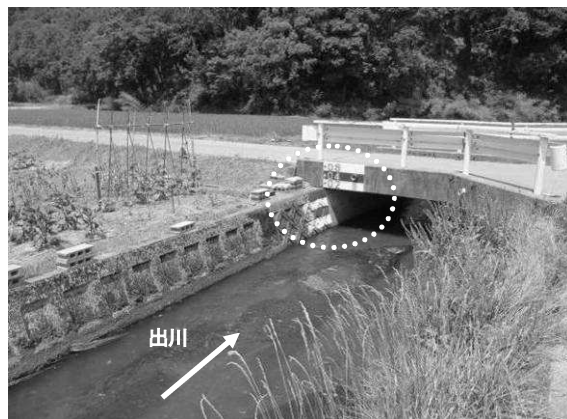
写-4 出川下流付近に設置した簡易量水標
