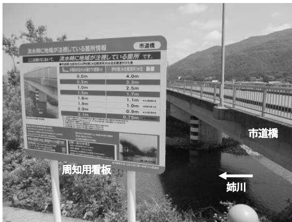
写-5 市道橋（姉川）に設置した簡易量水標と周知用看板
