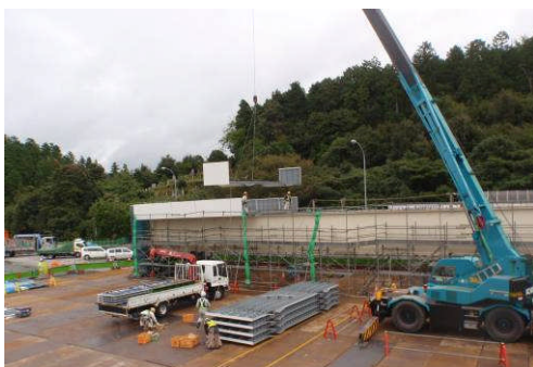
図-7 合成床版パネル設置状況
