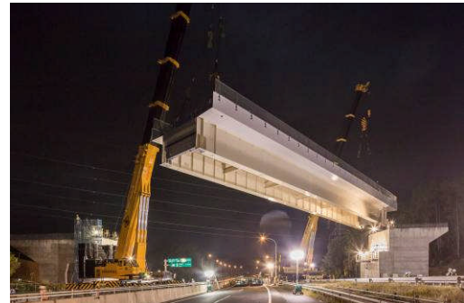
図-9 550tクレーンの相吊りによる架設状況
