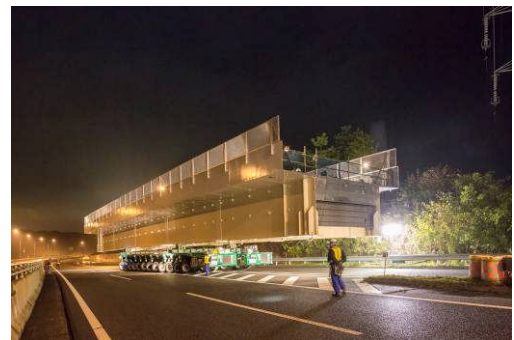
図-8 地組桁を載せた多軸台車
