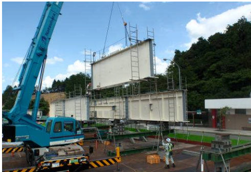
図-6 施工ヤードにおける主桁組立状況
