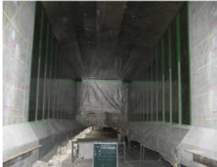
写真2-3プライマー塗布の完了状況
