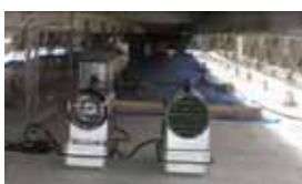
写真2-4ジェットヒータ設置状況
