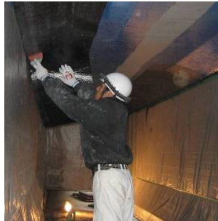
写真2-5炭素繊維貼付状況
