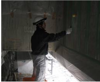
写真2-2ローラによるプライマーの塗布状況
