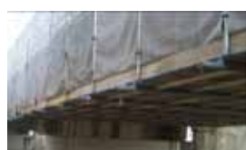
写真2-5足場設置状況
