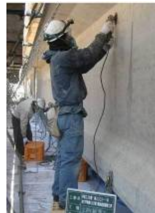
写真2-1 下地処理状況
