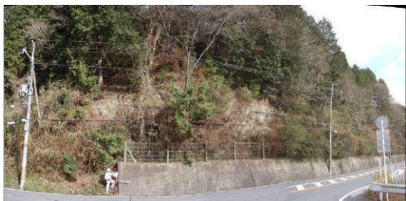
写真-4 法面4現況
