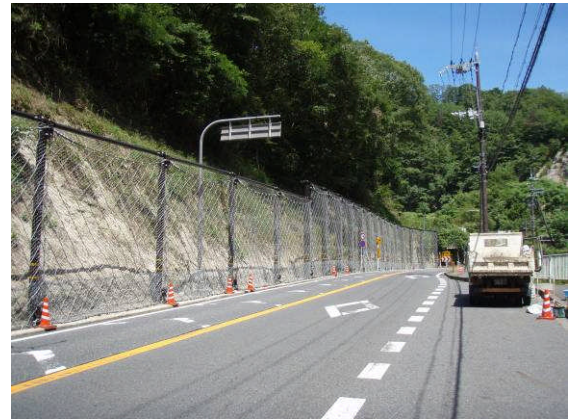
写真-7 法面1 施工完了
