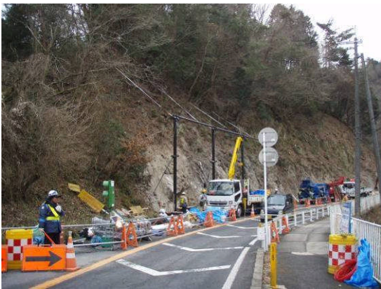
写真-5 法面2 交通規制状況
