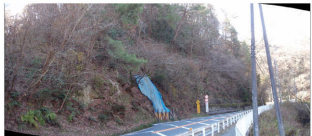
写真-2 法面2現況
