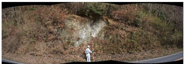
写真-3 法面3現況
