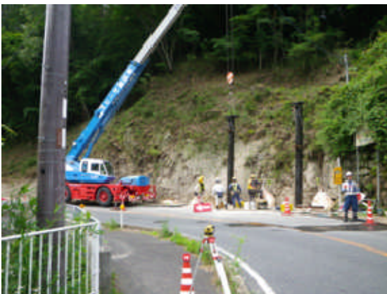
写真-6 法面1 支柱建込状況
