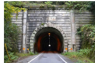
図-15 谷坂隧道(M) S10完成
