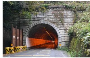
図-13 観音坂隧道(M) S8完成
