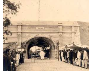
図-11 百瀬川隧道写真 T14完成
