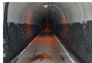
図-2 柳ヶ瀬隧道 レンガ部は部分的にモルタル補修
