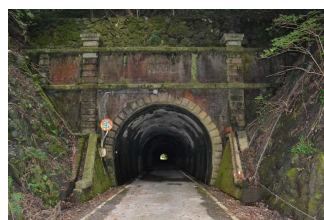
図-10 横山隧道写真(M) T12完成
