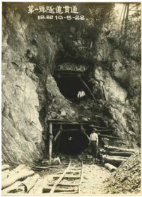
図-6 大崎第1号隧道 貫通 S10.5.22 撮影
