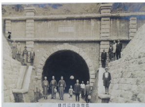
図-9 佐和山隧道(M) T12完成
