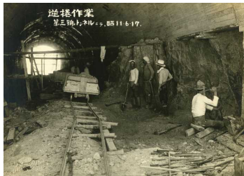
図-8 大崎3号隧道 逆捲作業 S11.6.17 撮影
