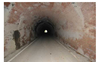
図-3 横山隧道 アーチ部、側壁部ともレンガ
