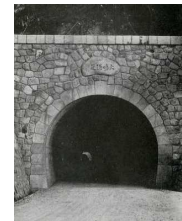
図-16 大崎隧道 S11完成
