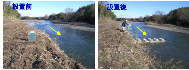
写真-2 試験施工の実施（水制工）
