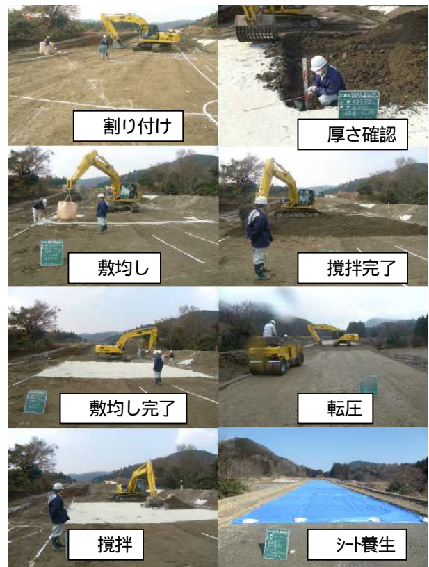
写真-1 吸着層施工フロー
