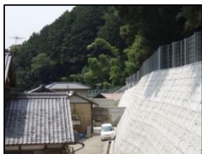
(急傾斜地崩壊防止施設)
