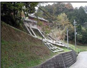
(急傾斜地崩壊防止施設)
