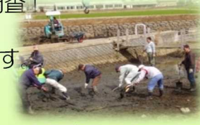
水質浄化池の泥上げ
