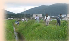
水路法面の草刈り
