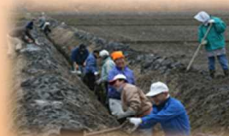
水路の泥上げ
