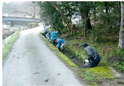
【水路の清掃作業】
