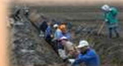
水路の泥上げ
