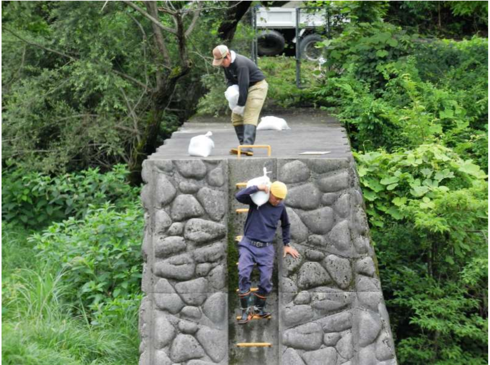
管理道がない
