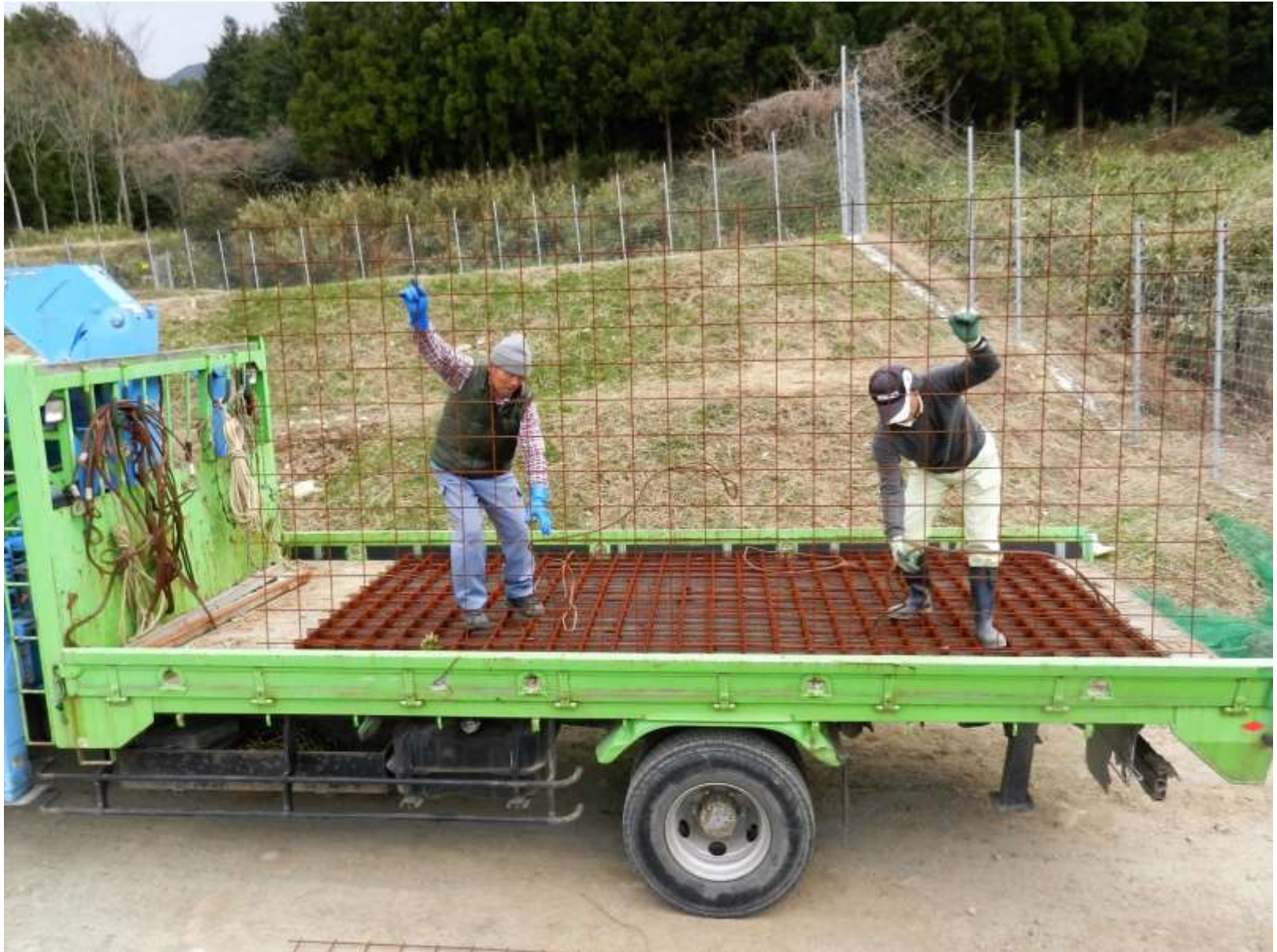
獣害柵の新設
