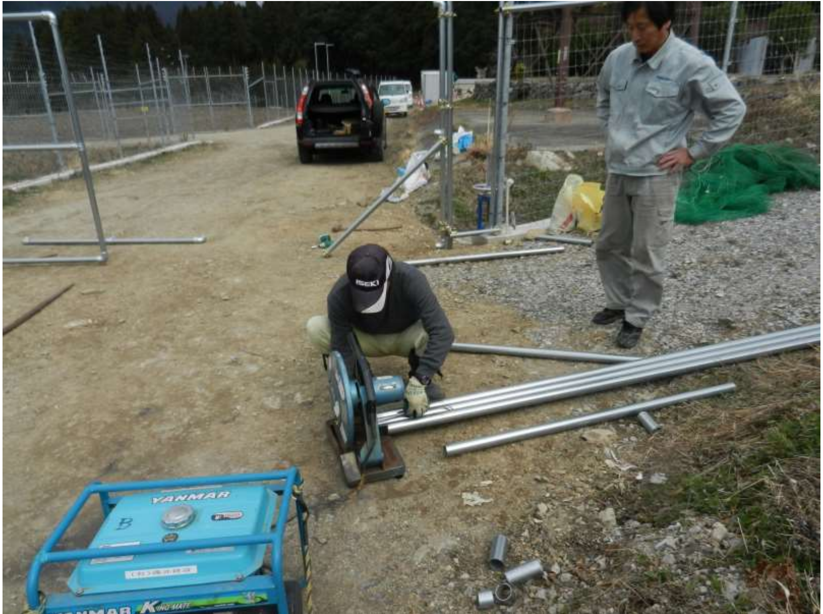
獣害柵の新設
