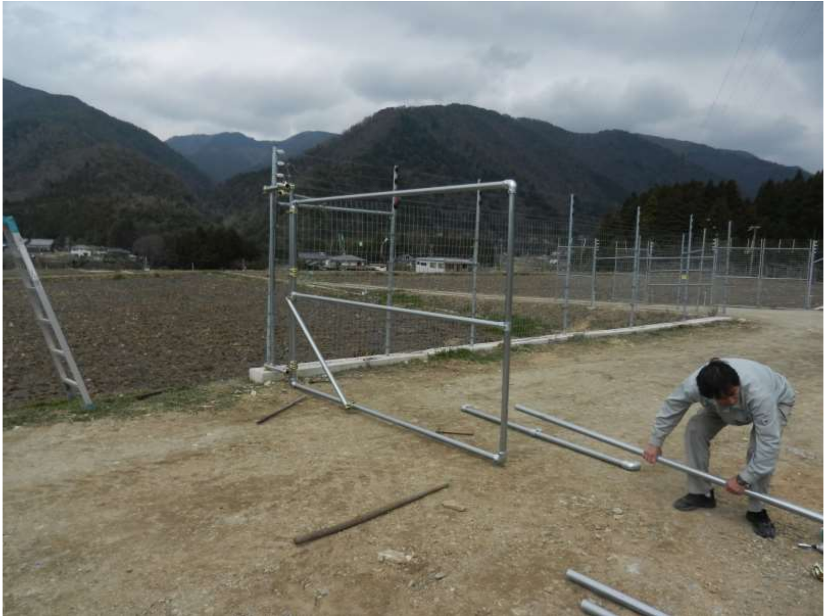
獣害柵の新設
