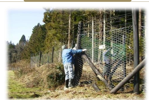
獣害防止柵の補修
