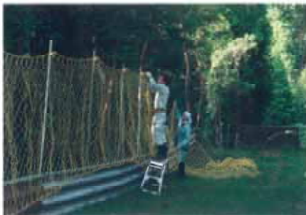
獣害防止柵の設置と補修
