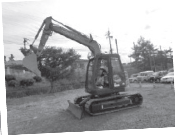
工事現場体験教室
